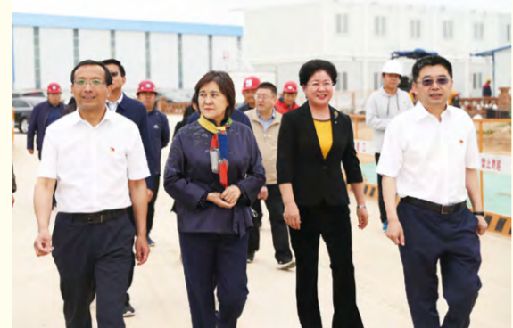
布小林主席来到我校和林格尔新校区建设工地，查看项目建设进展情况
